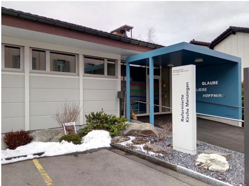
Der Eingangsbereich des Chileli Menzingen wurde neu gestaltet.
