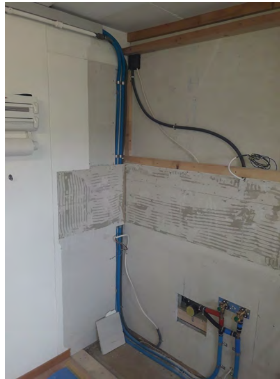
Rohmontage der Küchenanschlüsse in Menzingen
