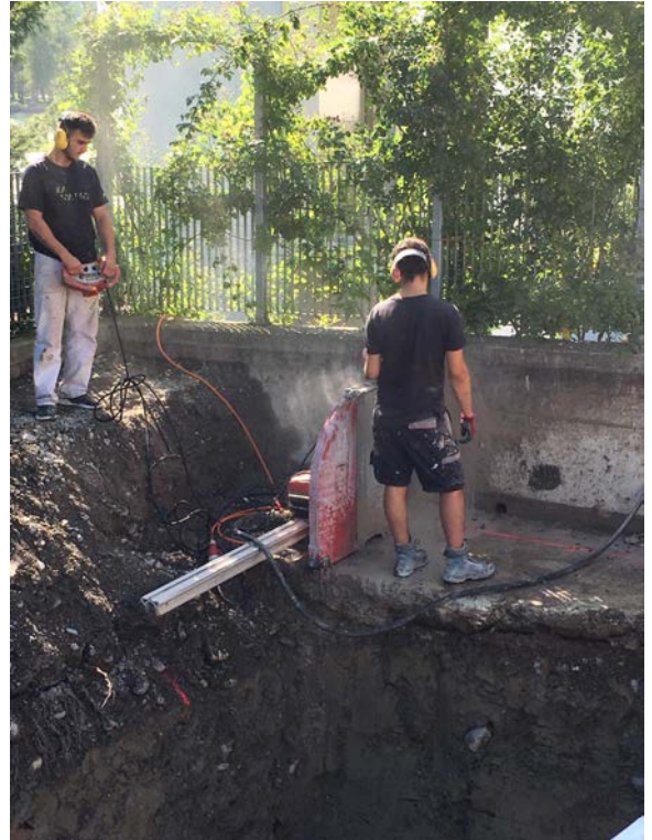
Aushubarbeiten für den neuen Gaskessel
