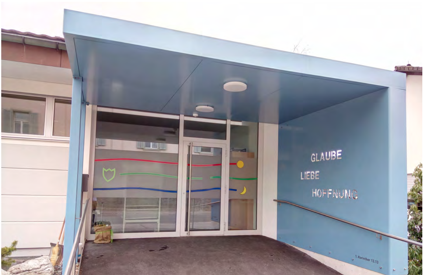
Neuer Eingang des "Chileli" Menzingen nach Sanierung
