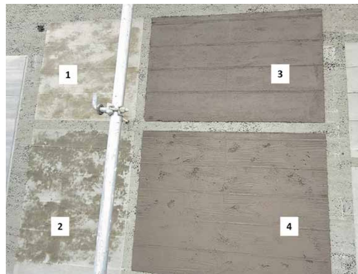
Testreihe zur Betonsanierung an der Aussenfassade der Kirche Rotkreuz.
